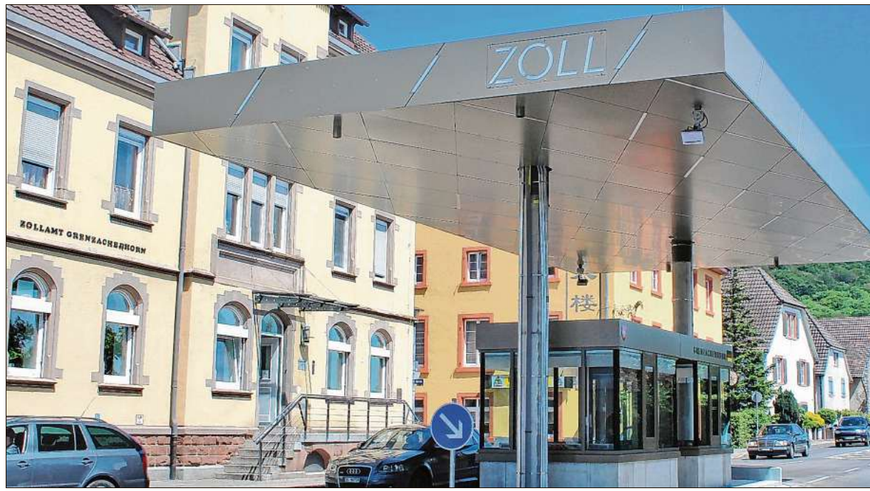
Das neue Zolldach und die Kabinen von der Schweizer Seite aus gesehen. Foto: Rolf Reißmann
